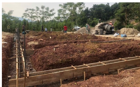
Les fondations (image prise en décembre)
